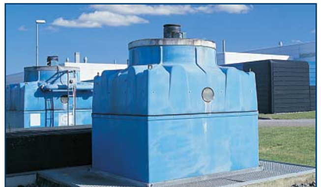
Рис. 3.7. Системы водяного охлаждения
